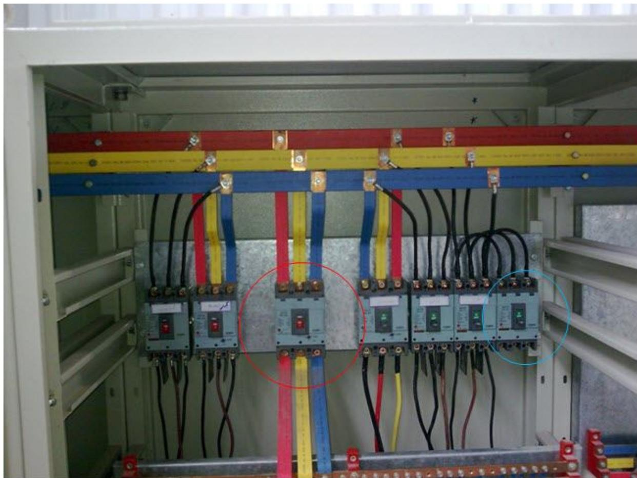
سه فاز از طریق یک کلید MCCB وارد قسمت بعدی که شینه های سوراخ دار هستند می شود. شینه های سوراخ دار توسط مقره های پلکانی به بدنه تابلو محکم می شوند. دلیل این امر هم این است که با استفاده از این مقره ها شینه ها در سه ارتفاع مختلف نسبت به هم قرار گرفته و سبیم کشی آنها راحت‌تر انجام می شود.
