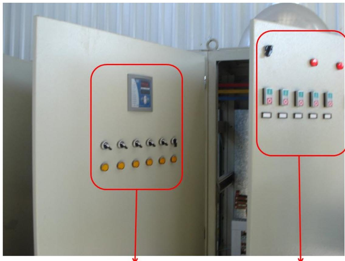
رگولاتور خازنی همراه با کنترل کننده های دستی آن
