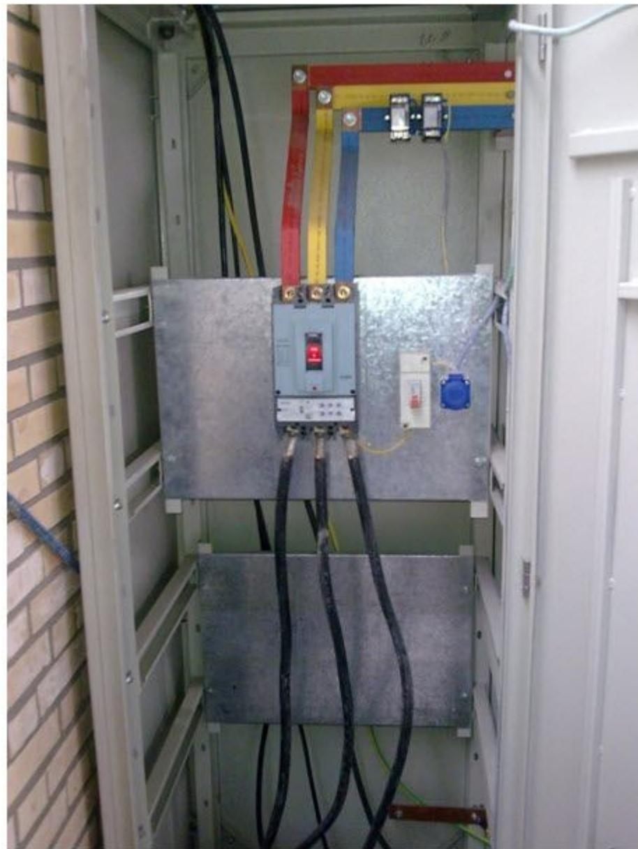
باید بدانیم که در تابلوهایی که جهت کنترل موتور های سه فاز کاربرد دارد بایستی از کلید های اتوماتیک MCCB به عنوان کلید اصلی تابلو استفاده کنیم
